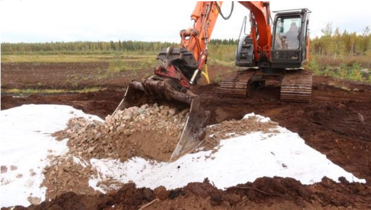
Osa-alueen 1 kiviverhoillun pohjapadon rakentamista 8.9.2025.
