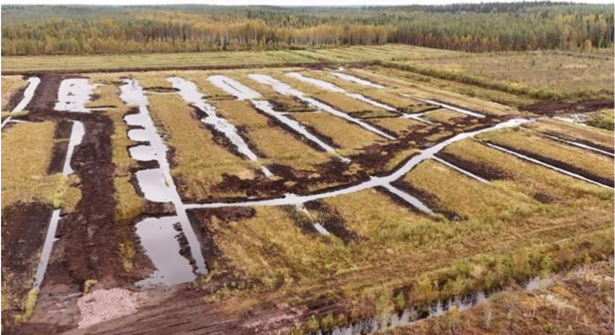
Liejusaaret kasattiin talvella ja samalla kaivettiin avouomia sarkaojien yhdistämiseksi. Kuvat 18.2.2025 ja 16.9.2025.
