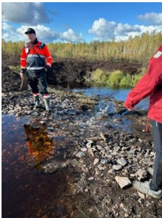
Kiviverhoiltu pohjapato 3l ohjausryhmän loppukatselmuksen yhteydessä 23.9.2025.
