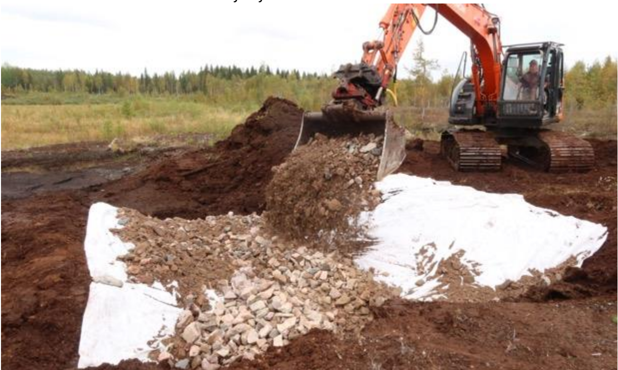
Osa-alueen 2 kiviverhoillun tulvakynnyksen rakentaminen 8.9.2025.
