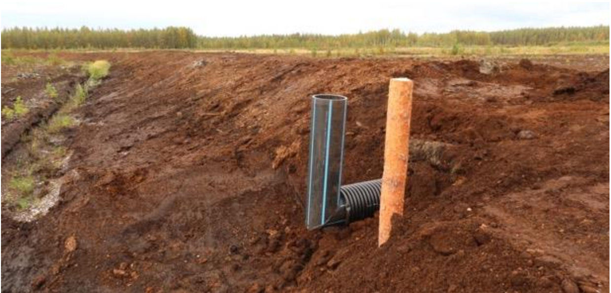
Kulmaputki paikalleen laitettuna 8.9.2025. Kuvaushetkellä siitä puuttuu vielä pystypuuhun kiinnitetty lankku, jolla pystyputken kulmaa voidaan säätää.
