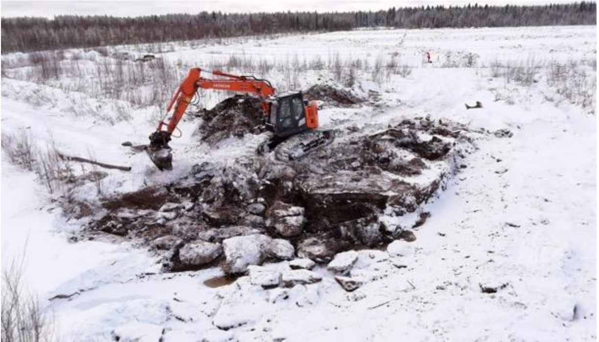
Kasvillisuuskentän 3f rakentamista 18.2.2025.
