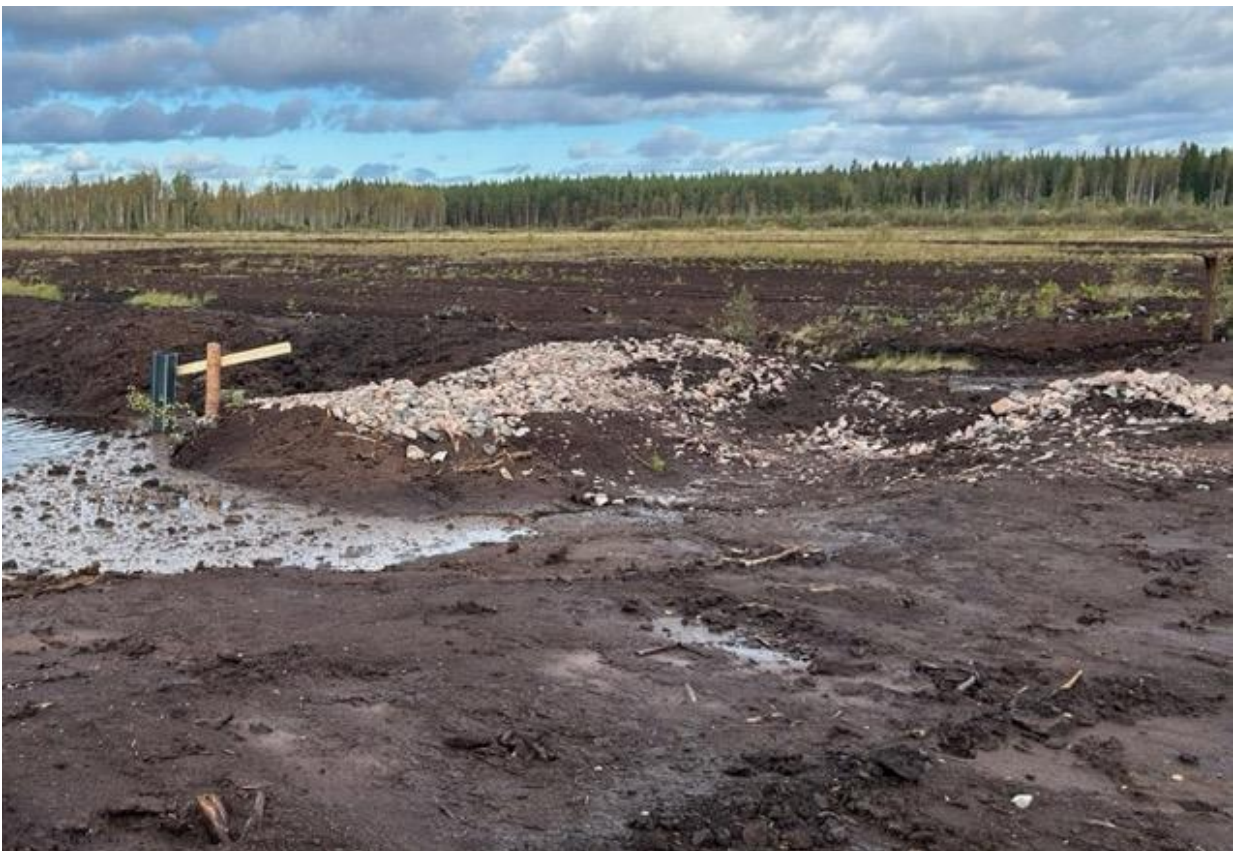
Kulmaputki ja kiviverhoiltu pohjapato valmiiksi rakennettuina. Kuva 23.9.2025.
