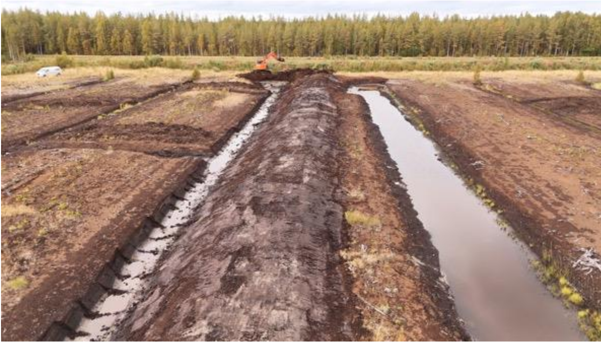
Patopenkereen 1d viimeistelyä 4.9.2025.
