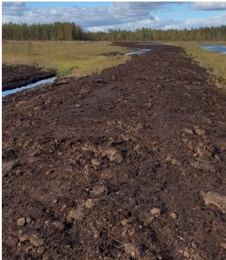
Osa-alueen 2 patopenger kasattuna talvella ja valmiiksi rakennettuna. Kuvat 13.2.2025 ja 23.9.2025.
