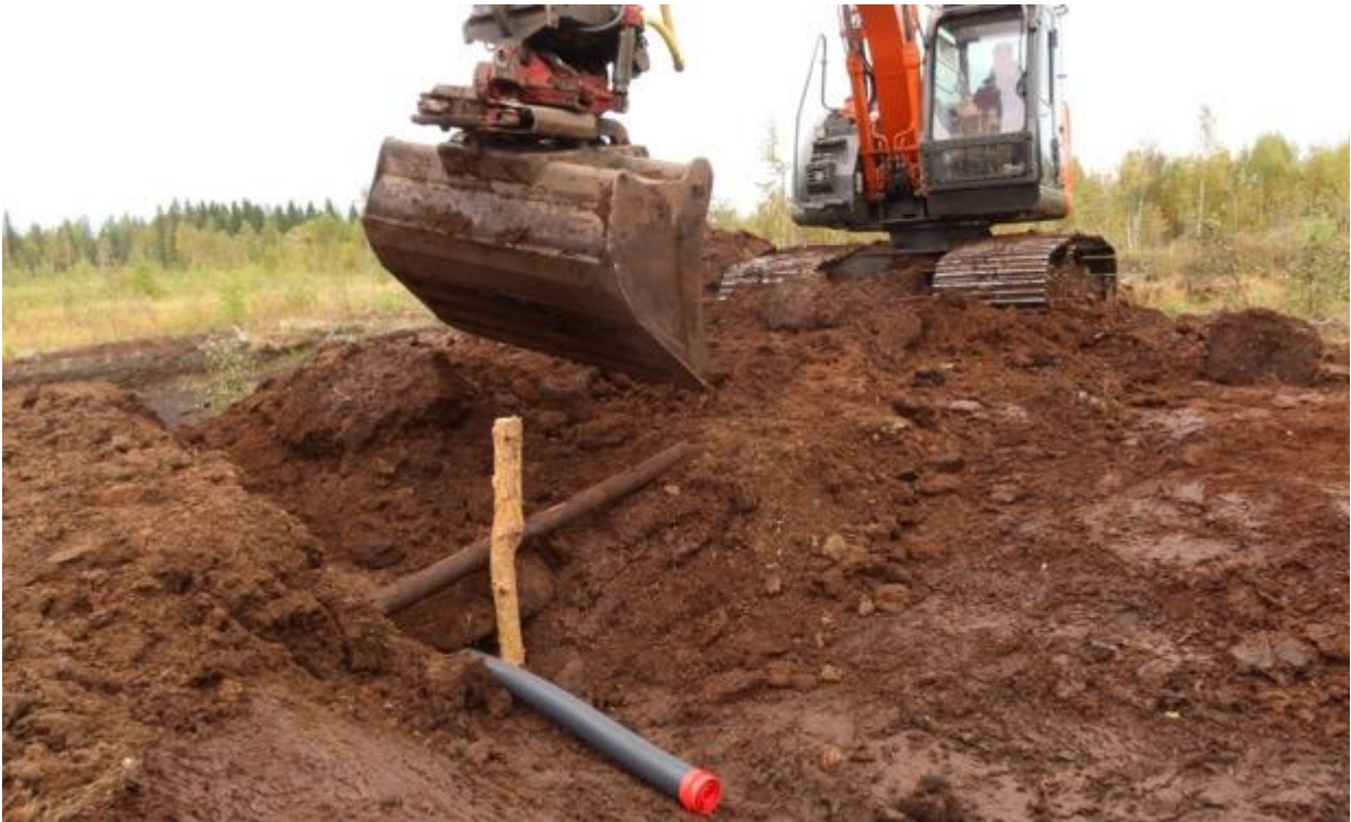
Osa-alueen 2 kulmaputken 2e asennus 8.9.2025.
