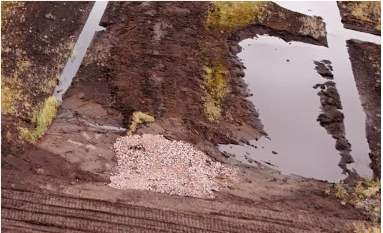
Joustava kulmaputki ja kiviverhoiltu tulvakynnys valmiiksi rakennettuina 22.9.2025.
