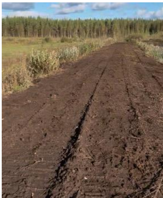
Tasoitettu reunapenger 3h, kuvat 16.9. ja 23.9.2025.
