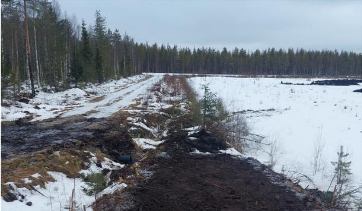
Rumpuputki 1b tulotiehen asennettuna, kuva 28.2.2025.
