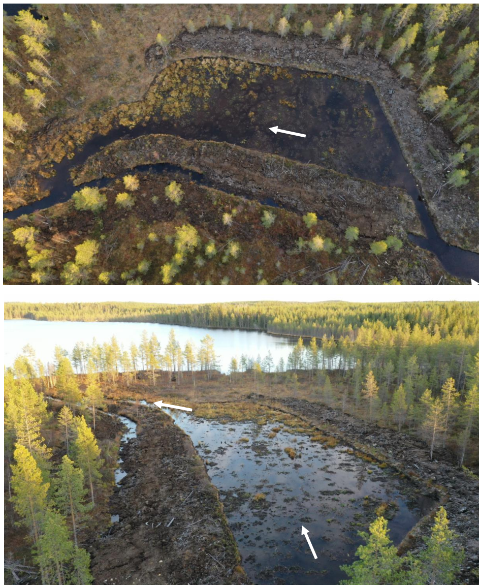
Kuva 38. Rakennettu kasvillisuuskenttä Taivalkosken Koviojärvellä 2 v rakentamisesta.
