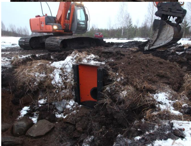
Kuva 30. Virtaamansäätöpadon asennuksen vaiheita.
