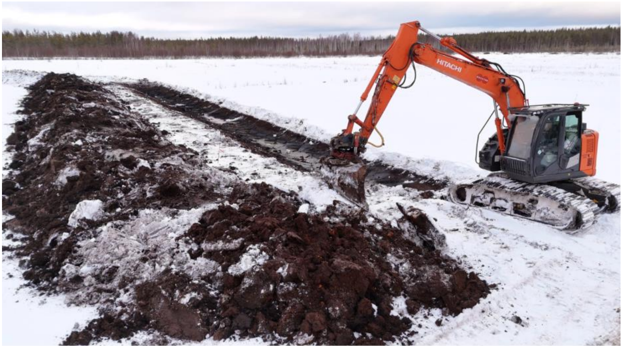
Kuva 1 Patopenkereen rakentamista tammikuussa 2025.
