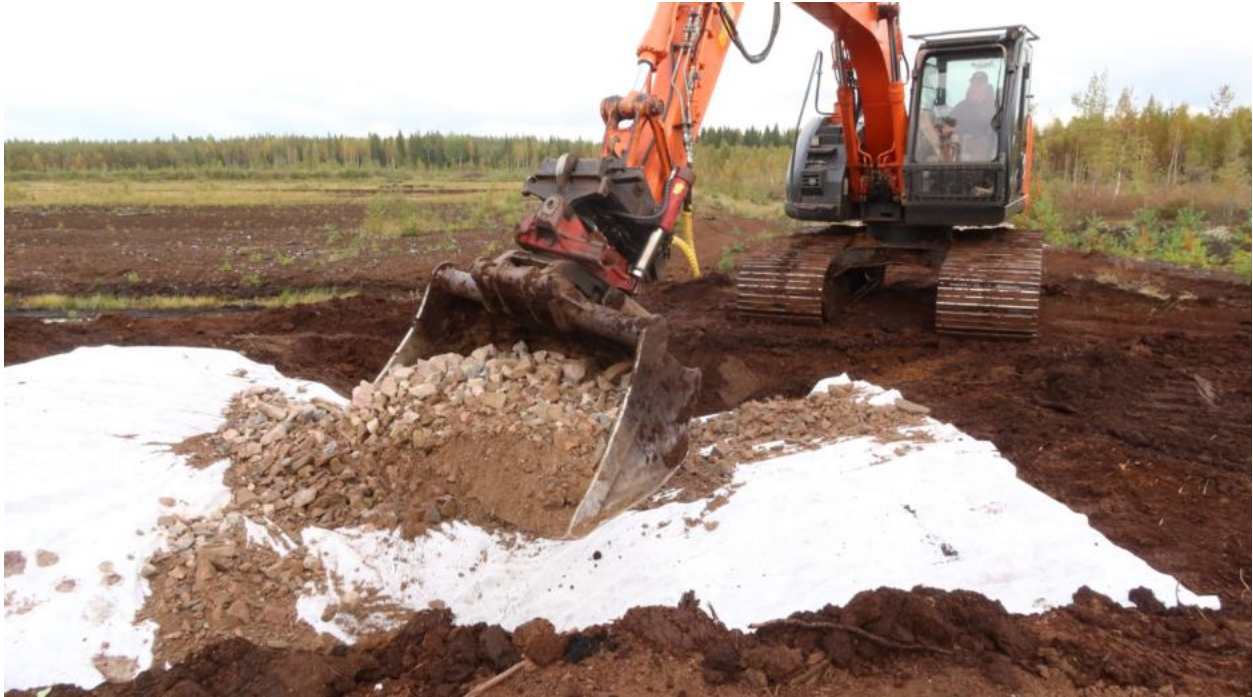
Kuva 2 Osa-alueen 1 kiviverhoillun pohjapadon rakentamista 8.9.2025.
